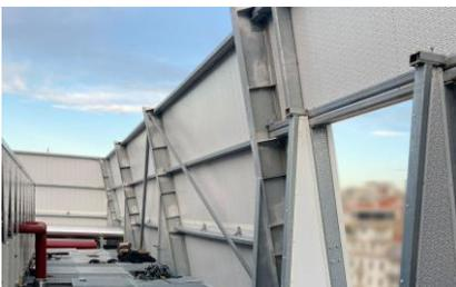
Les écrans acoustiques AD Ingénierie sont destinés à protéger des zones sensibles des nuisances sonores provoquées par un équipement industriel. Les écrans ADEC peuvent être installés à l'intérieur comme à l'extérieur. Construits à partir d'une base standard en panneaux acoustiques absorbants, les écrans ADEC ont un affaiblissement compris entre -5dB et -20dB suivant les conditions du site.
